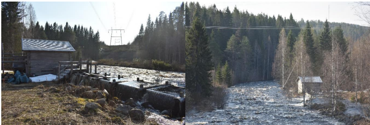
Kuva 32. Karppalan mylly ja alueen yli kulkeva 220 kV voimajohto. (Kuvat: Minna Takalo, FCG).
