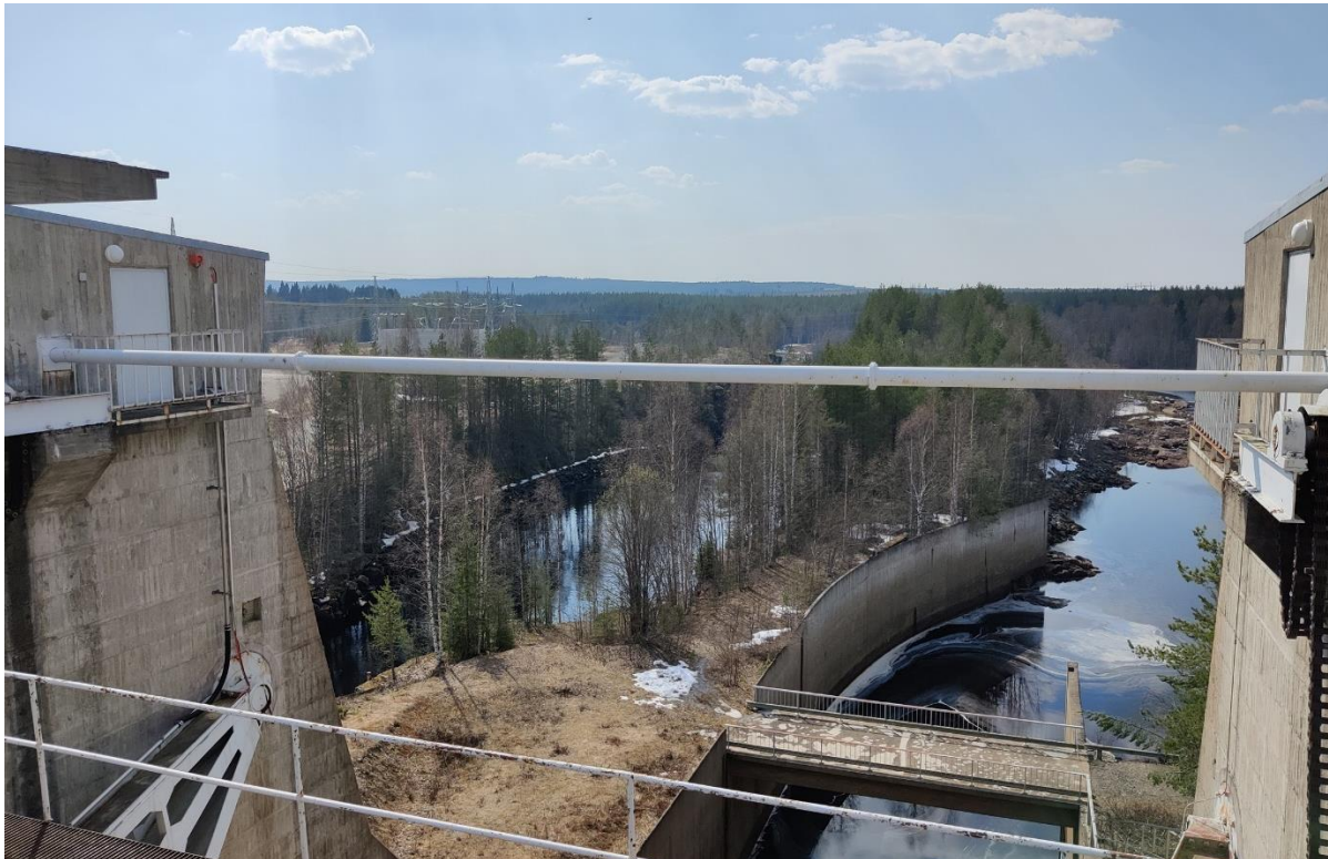
Kuva 33. Oulujoen ja Sotkamon reitin voimalaitokset (Seitenoikean voimalaitos). Seitenoikean sähköasema näkyy taka-alalla. (Kuva: Minna Takalo, FCG)
