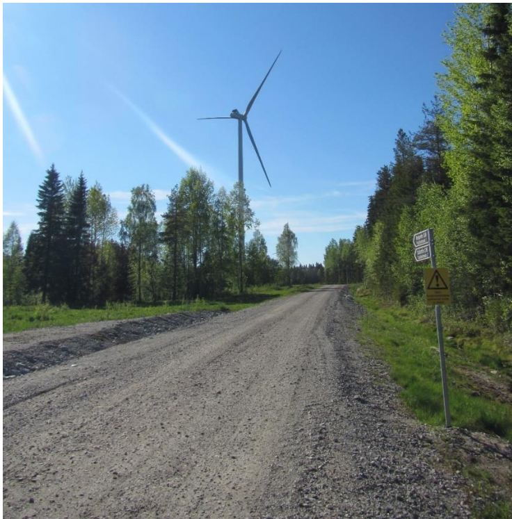
Kuva 2-5. Esimerkki tuulivoimapuiston huoltotiestä (© AFRY Finland Oy).
