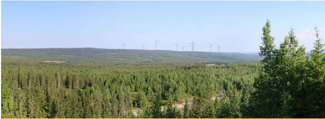
Kuva 8-8. Puolangan ja Ristijärven voimalat Paljakan laskettelukeskuksen huipulta katsottuna. Etäisyys on noin 6 km.
