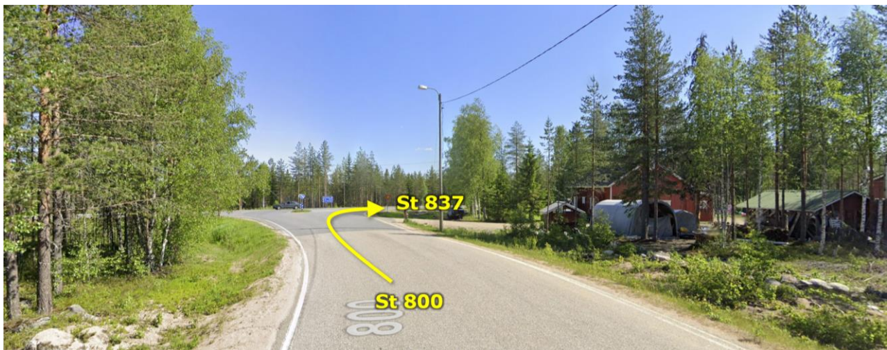
Kuva 12: Seututien 800 jyrkkä mutka sekä lähellä sijaitsevat rakennukset (POS C4)
