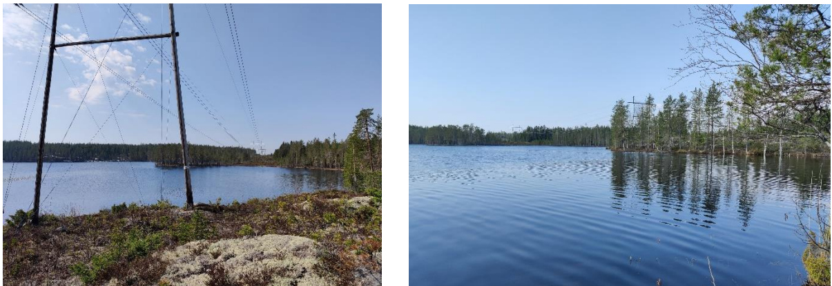
Kuva 41. Iilammen ylittävä 220 kV voimajohto itärannalta kuvattuna (vas.) sekä johtokäytävän suuntaan koillisrannan mökkirannasta kuvattuna (oik.).
