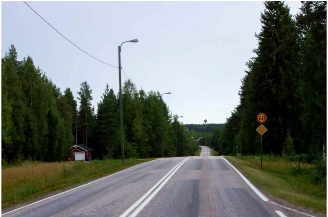
Kuva 46. Näkymä Pudasjärventien ja Niskanperäntien risteysalueelta kohti Puolangan keskustaa.
