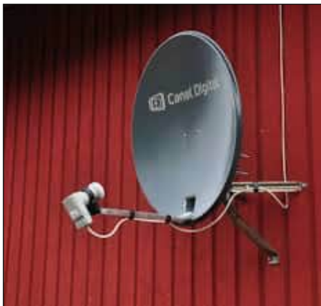
Kuva 9. Esimerkki satelliittiantennin asennuksesta.
