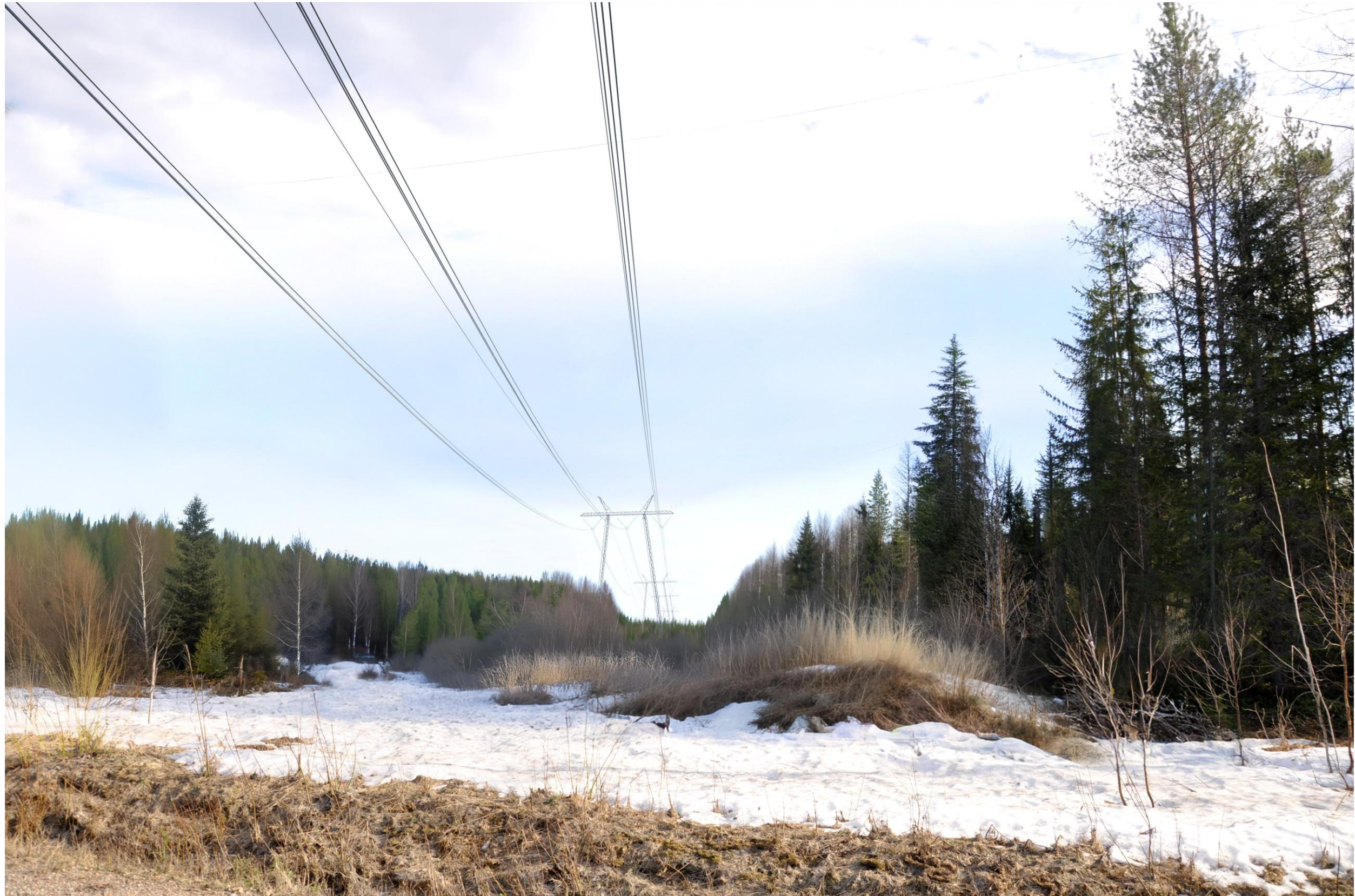
Kuva 92. 400 kV voimajohdon kuvasovite sähkönsiirron vaihtoehdon SVE 2B reitiltä, kuvauspaikasta SS1 (~Kongasmäentie 45)
